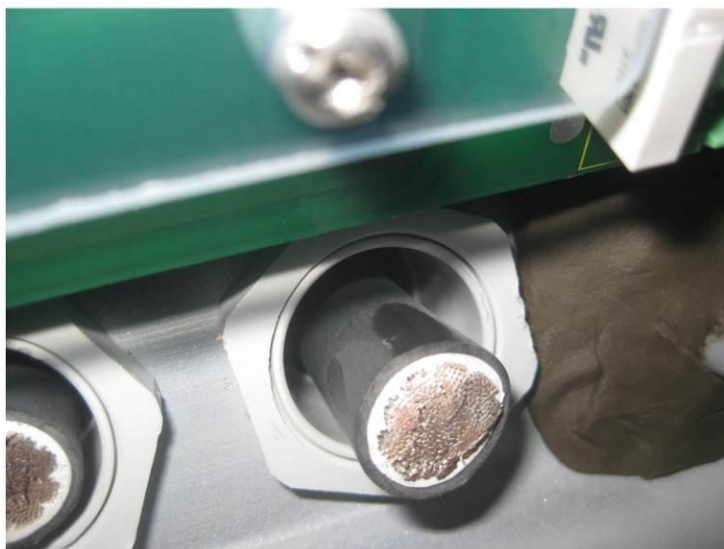
Bild 4: Detailbild Prüfling, exemplarisch
