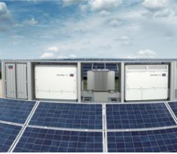
Karadoc 太陽能電廠位於澳大利亞維多利亞州，電廠規模 112MW，由 BayWa 公司承建，SMA 提供的 19 台中壓逆變一體機確保太陽能發電的順利進行。
