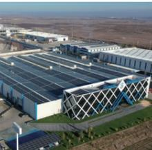
土耳其工業設備製造商Şimşek Alüminyum A.Ş.近期在其廠房屋頂上建造太陽能電廠，以滿足企業大約50%至60%的能源需求。SMA為其提供了17台 Sunny Tripower CORE2 110kW太陽能變流器，每年可提供 2,829MWh 的可再生能源，同時可減少約1,368噸的二氧化碳排放量。
