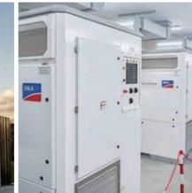
由於採用了SMA儲能系統，博德斯霍姆鎮成為德國第一個與公用電網斷開連接並100%提供可再生能源一小時的城鎮，最後成功地重新連接到電網。除了實現電網功能外，SMA儲能變流器還配備了可選的「黑啟動」功能，可以在斷電後重新啟動整個電力供應。
