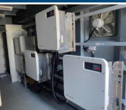
位於台灣台南學甲地區 76MW 太陽能電廠於 2020 年 12 月正式並網，這是台灣首個直流側 1500V 大型地面太陽能電廠。SMA 與工程總承包方聚恆科技股份有限公司合作，向該專案交付了 445 台 SUNNY HIGHPOWER PEAK3 150kW 太陽能變流器。
