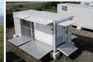
專案位於加勒比海St. Eustatius 島，目前太陽能供電佔總電力需求的46%。SCS 2200儲能變流器搭配5.9MWh的鋰離子電池可在柴油機關閉模式下運行孤島電網10.5小時。
