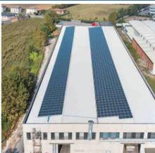
鋼鐵加工公司對能源的需求很高。為了降低電費並保護環境，來自意大利的Sider Center Service s.r.l. 公司目前正在使用太陽能實現清潔能源供電，在工廠屋頂安裝了Sunny Highpower PEAK3組串式變流器，每年可產生約500 MWh的可持續電力。每年可為公司節省約70,000歐元，並減少4500噸的二氧化碳排放量。
