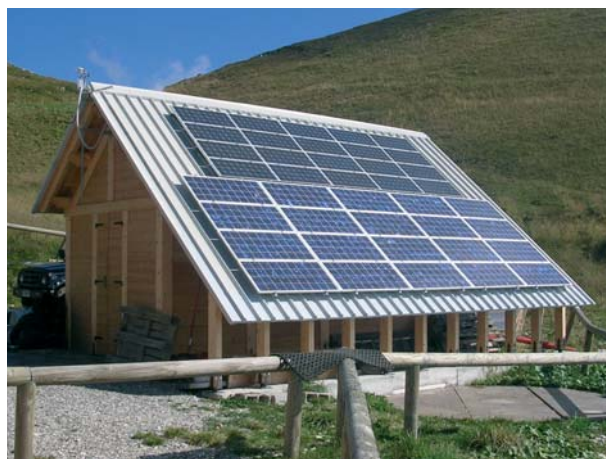
Fig. 9.2 : Refuge alpin alimenté en courant photovoltaïque
