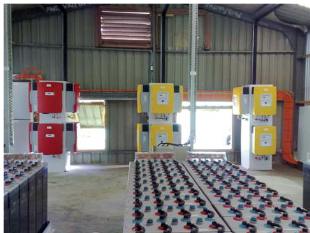
Fig. 9.4 : Système photovoltaïque hybride dans une école de Vaitupu, dans l'archipel des Tuvalu (océan Pacifique)
