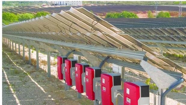
Abb. 6: Wechselrichtermontage in sechser Gruppen bei einer aufgeständerten Freiflächenanlage
