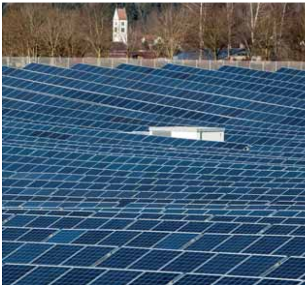
4,9 MW Solaranlage Leutkirch im Allgäu, gebaut von ALPINE ENERGIE Deutschland GmbH, betrieben von EnBW.
