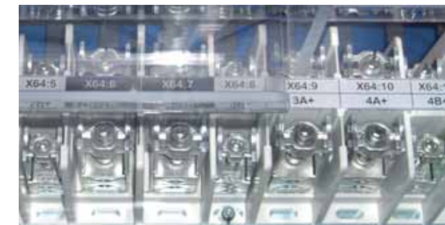
DC-Anschlussbereich im SUNNY CENTRAL CP mit Käfigklemmen.
